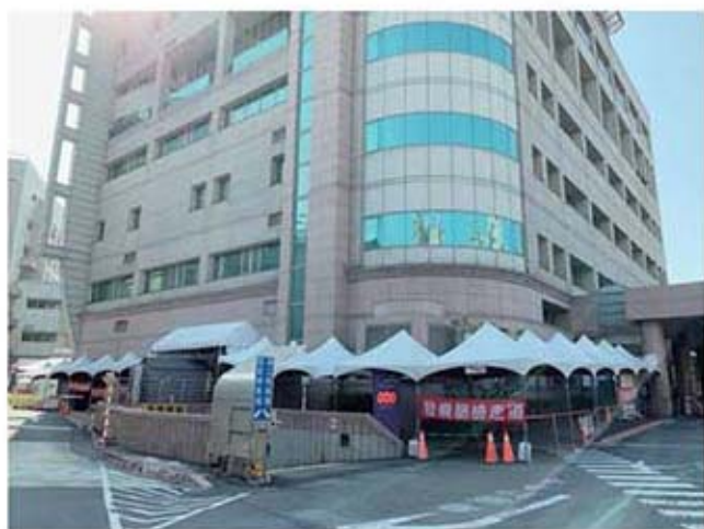
圖三、急診戶外發燒篩檢站
